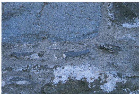
Pinningsteiner (Stjørdalsskifer) i nordmuren til Vesthuset
