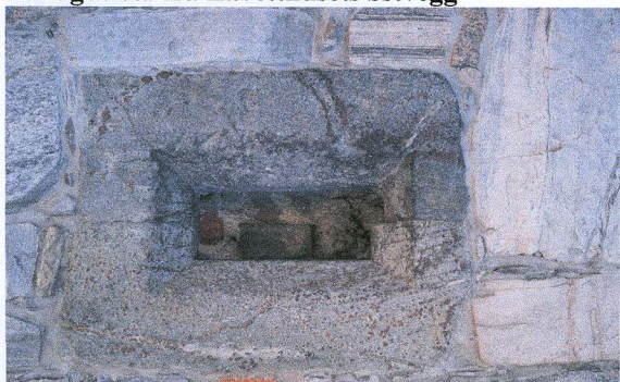
Gjenmuret skyteskår innfelt i Lavetthuset's østvegg omkranset av kleberstein
