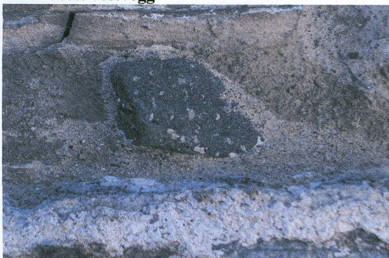
Sort porfyr brukt som pinningstein i Lavetthusets nordvegg
